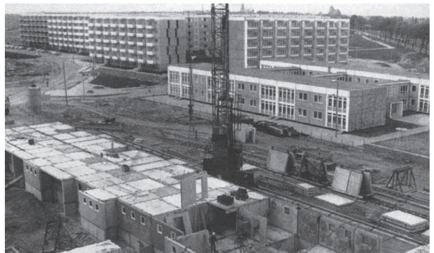
Das „Baukastenprinzip“ in Schönwalde I: Plattenbauten am Dubnaring / Loissiner Wende.
