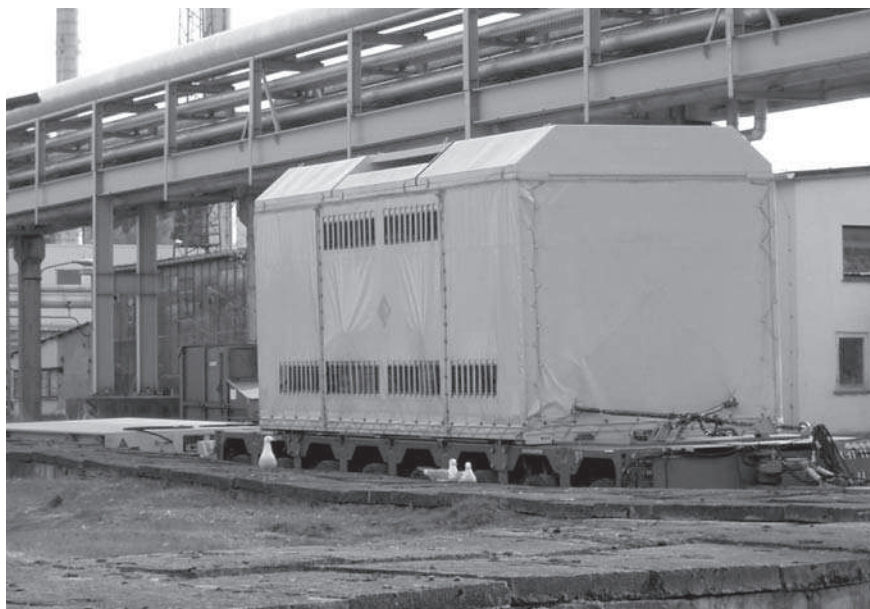
Ein Castorwagen auf dem Gelände des AKW Lubmin.
